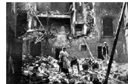
◆ Séisme de Lambesc (Bouches-du-Rhône), 11 juin 1909 - Source CEA
